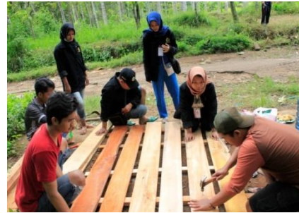
Gambar 5. Proses pemasangan papan kayu
