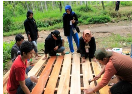
Gambar 5. Proses pemasangan papan kayu
